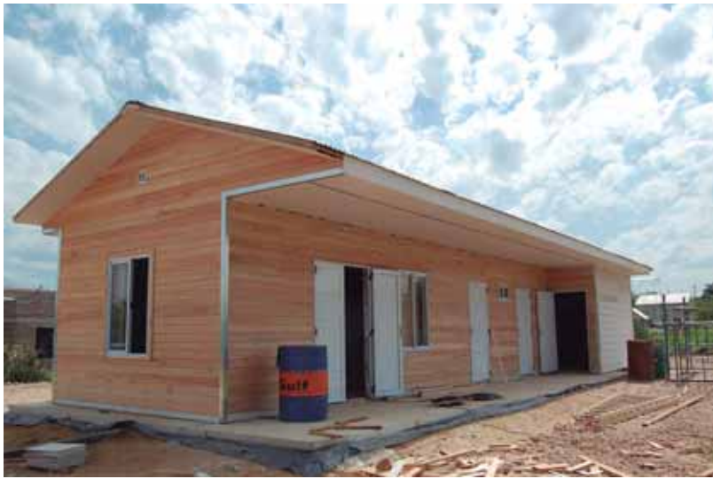
Casa construida por INTA Concordia en la localidad entri-riana de San José.
