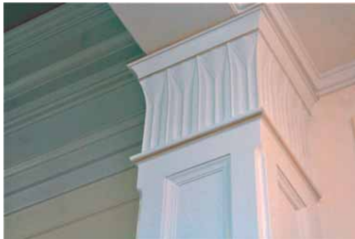
Se utilizó carpintería laqueada para molduras de revestimiento.
